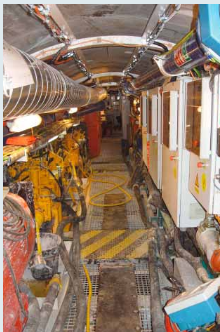
Eingeschränkte Platzverhältnisse auf der Vortriebsmaschine.
