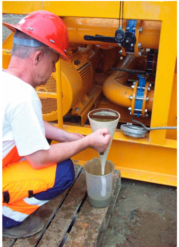
Ingenieur bei der Spülungskontrolle.
