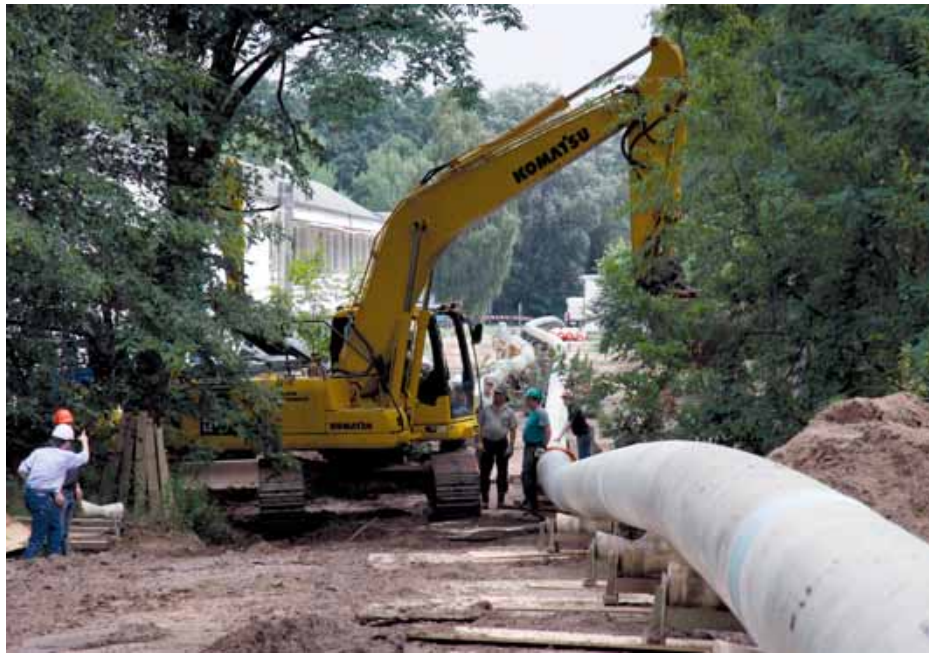
Rohrstrang auf Montagebahn.
