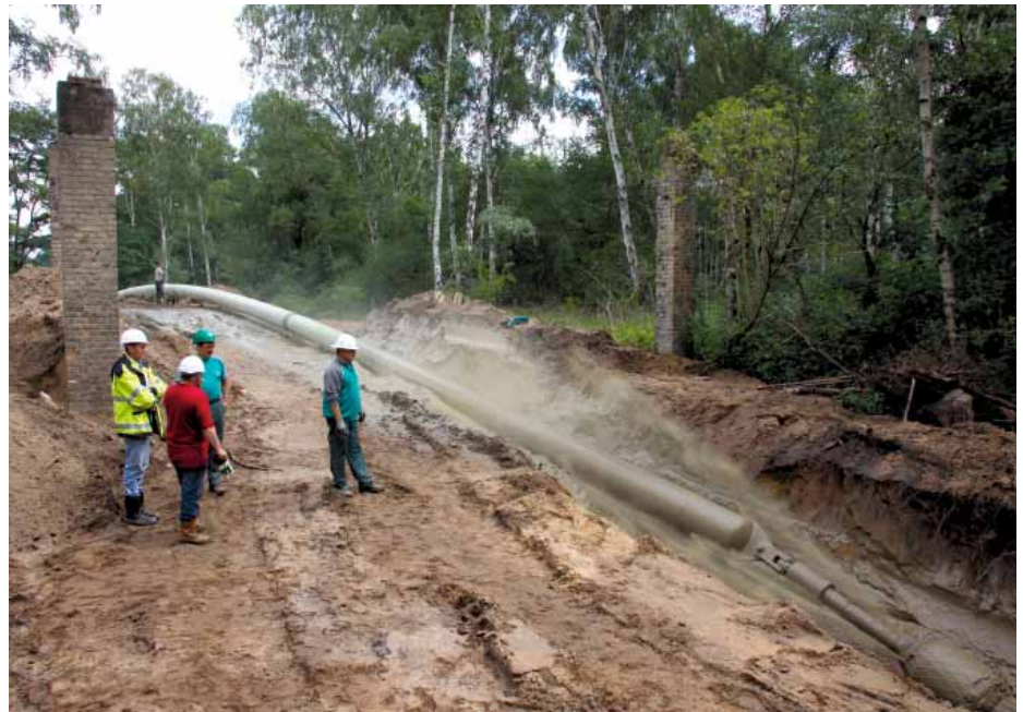
Beginn des Rohreinzugs.
