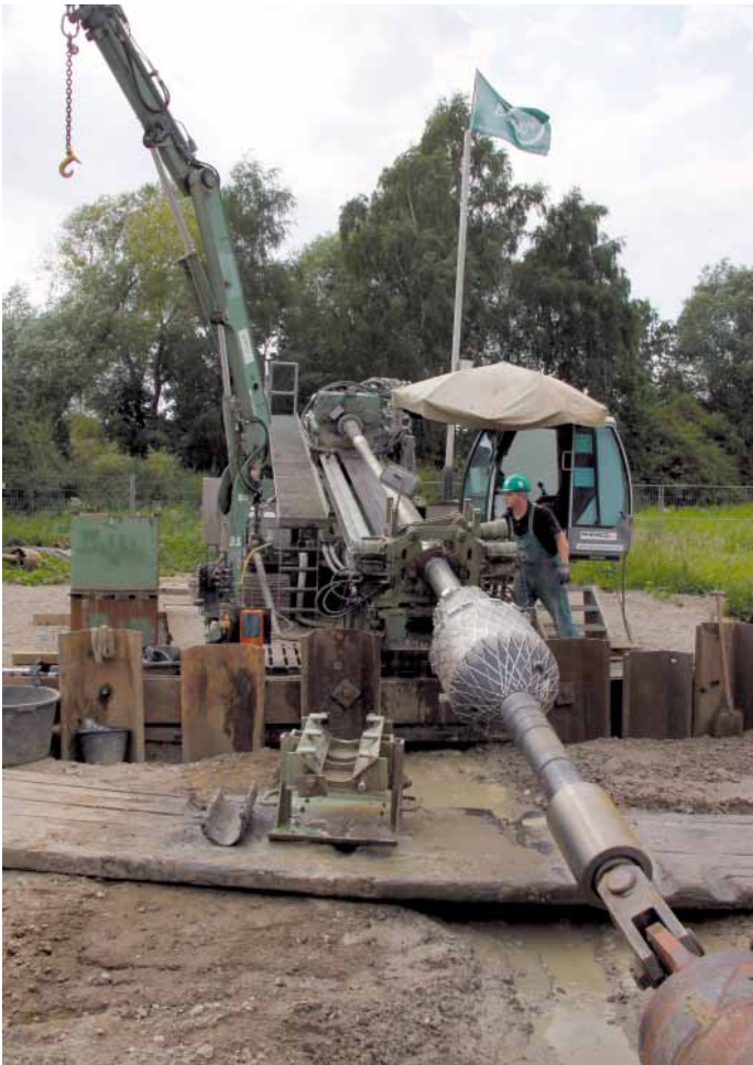
Die eingesetzte 100-Tonnen-Bohranlage.
