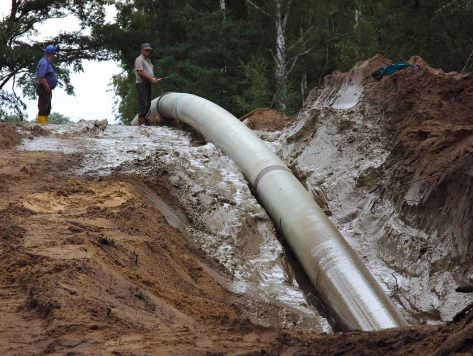
Aufgefüllter Oberbogen beim Rohreinzug
