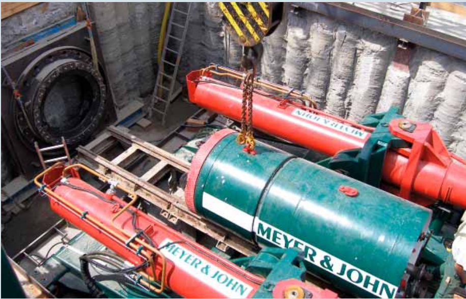
Der Bohrkopf wird in Stellung gebracht.
