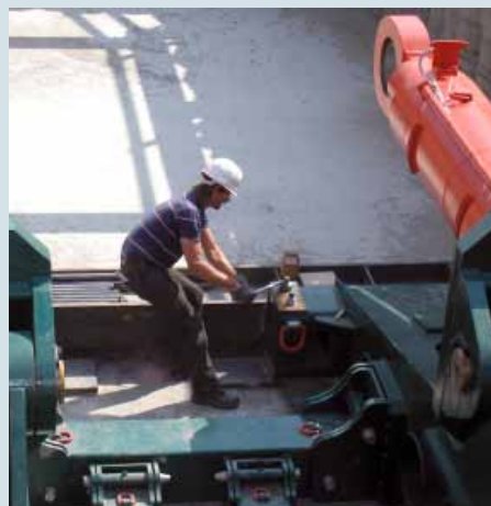
Verankerung des Pipe Thrusters in der Bodenplatte der Startbaugrube.
