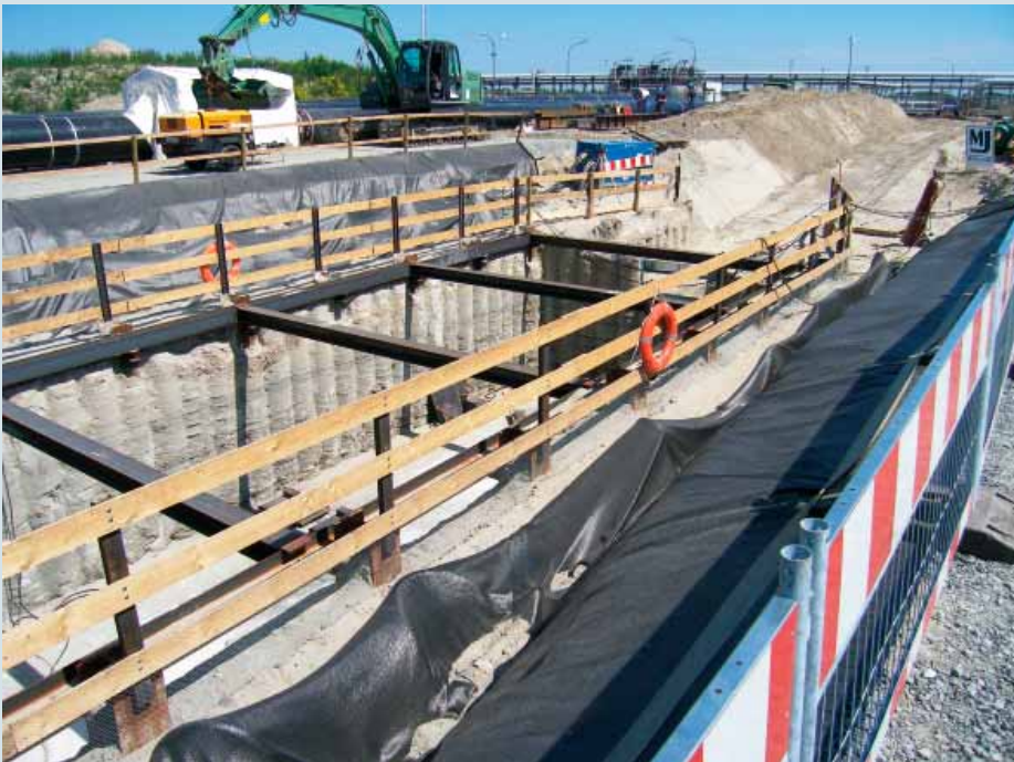
Die Startbaugrube musste so hergestellt werden, dass die hohen Vorschubkräfte des Pipe Thrusters in den Baugrund eingeleitet werden konnten.
